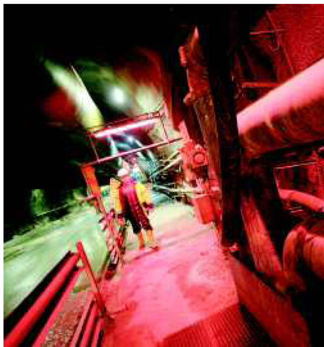
In Val Susa si lavora agli scavi per l'Alta velocità ferroviaria
