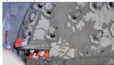
La talpa "Anna" è arrivata, a sinistra la testa della fresa da cui escono gli operatori francesi, sotto in dettaglio con le bandiere. Sopra il diaframma prima del crollo.
