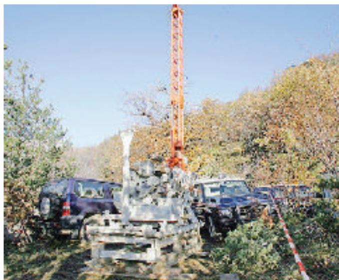
In Valsusa stanno per tornare le trivelle per i sondaggi sui terreni della Tav
