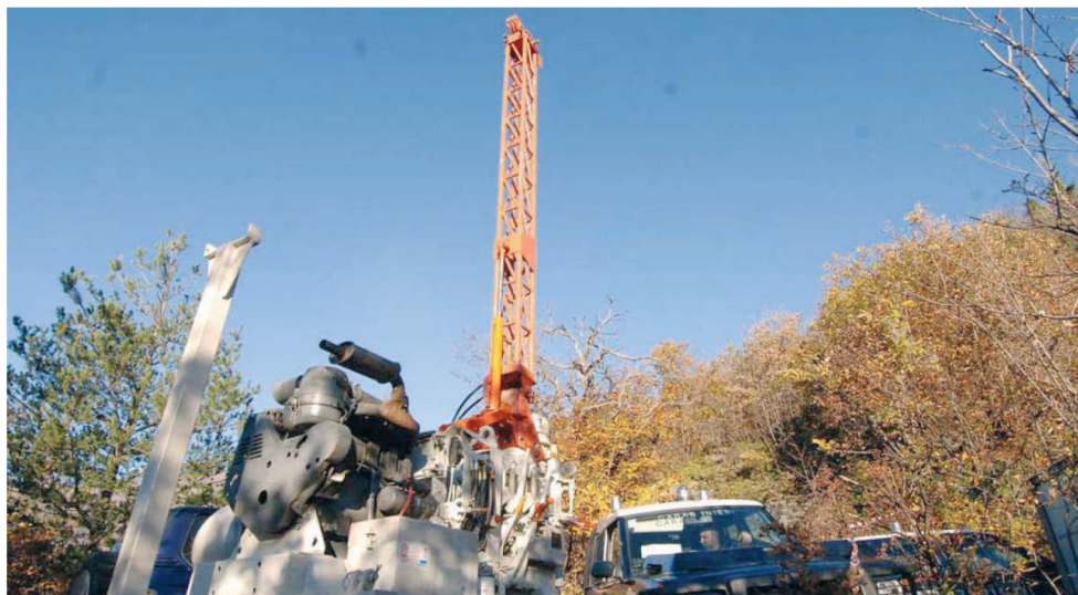
NUOVI CAROTAGGI Le trivelle sono arrivate anche a Buttigliera e, sul territorio di Torino, tra via Monginevro e Strada della Pronda
