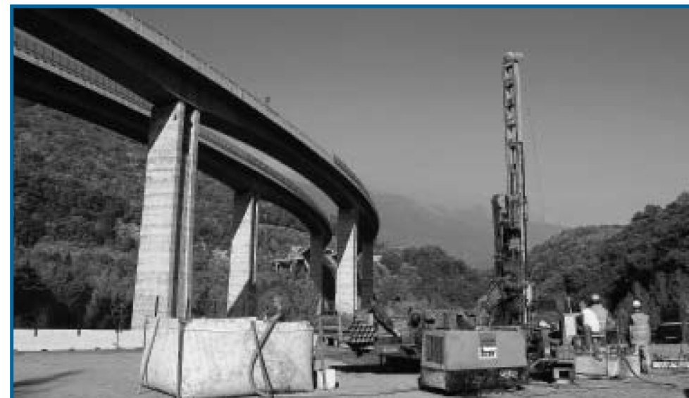
La prima trivella ha cominciato i "sondaggi" nei pressi del viadotto dell'A32
