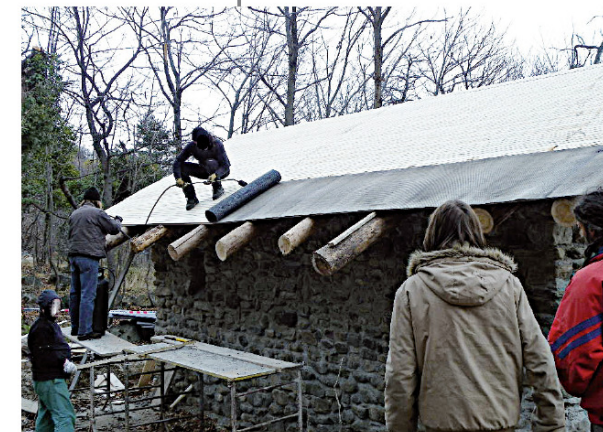
I lavori sul tetto del presidio e (a sin.) la roulotte che ospita gli attivisti accanto alla costruzione
