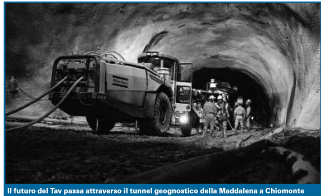
Il futuro del Tav passa attraverso il tunnel geognostico della Maddalena a Chiomonte
