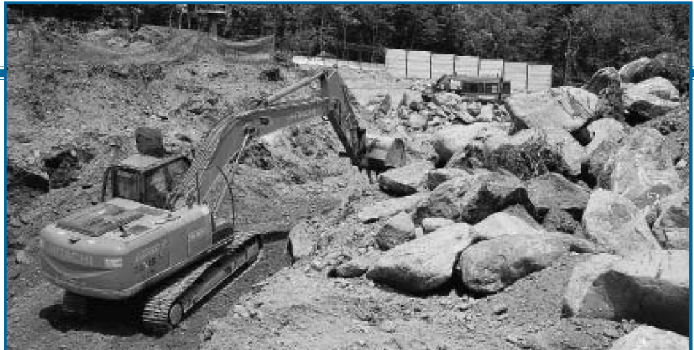
I lavori all'interno del cantiere di Chiomonte
