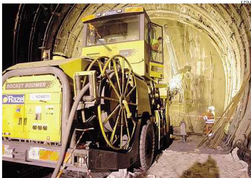
► Un'immagine delle discenderie già realizzate in Francia
