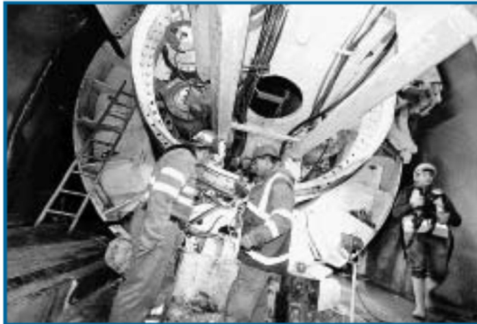
La "talpa" nel cantiere Tav di Chiomonte
