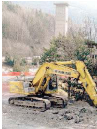
Il cantiere al Frejus
