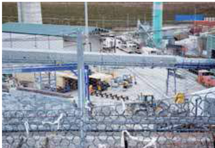
Il cantiere della Maddalena di Chiomonte (foto Diego Fulcheri)
