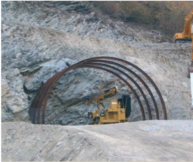
CAROTAGGI il piano predisposto dalla prefettura non ha subito alcuni stop. Si lavorerà anche nei prossimi giorni
