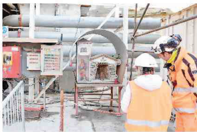
Mercoledì si riunirà il tavolo tecnico sul futuro del cantiere
