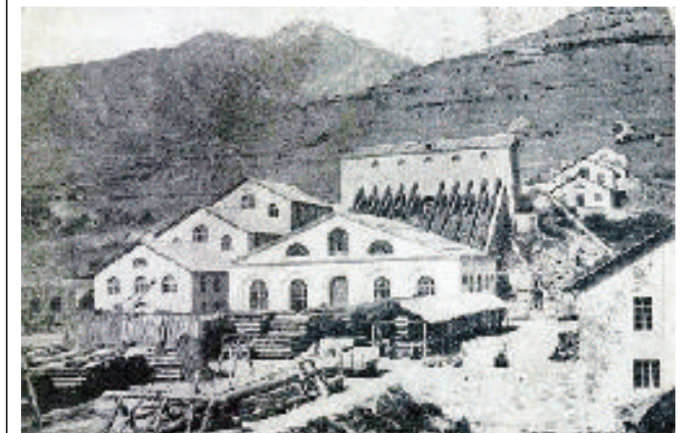
I cantieri dei compressori che azionavano i perforatori meccanici
