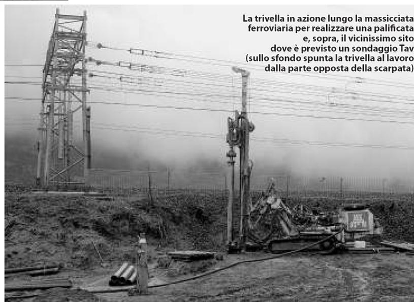
La trivella in azione lungo la massicciata ferroviaria per realizzare una palificata e, sopra, il vicinissimo sito dove è previsto un sondaggio Tav (sullo sfondo spunta la trivella al lavoro dalla parte opposta della scarpata)
