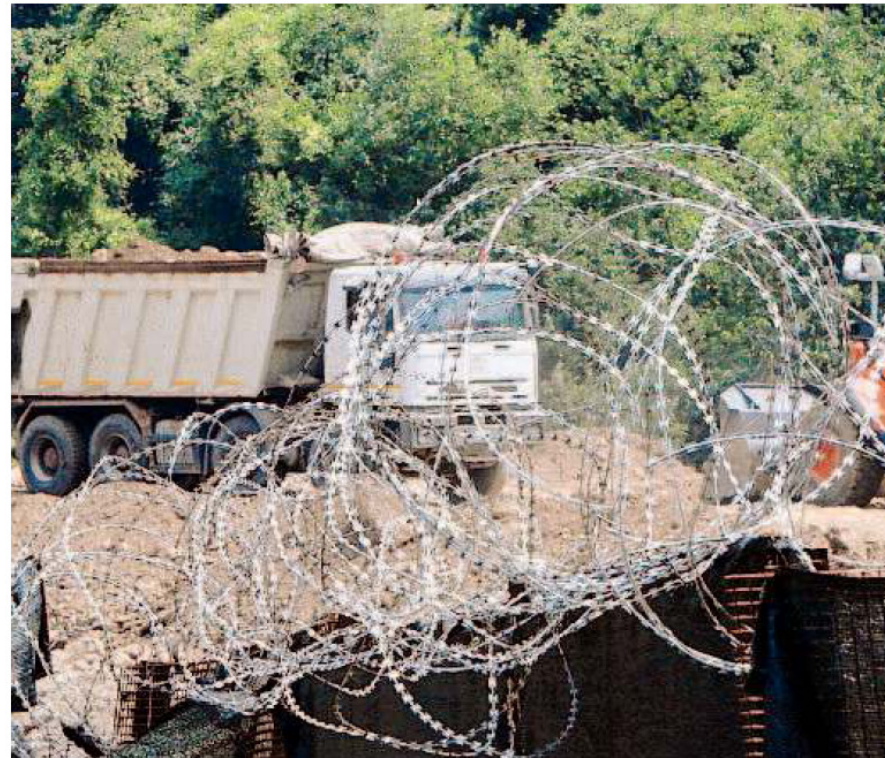
Il cantiere della Tav a Chiomonte
