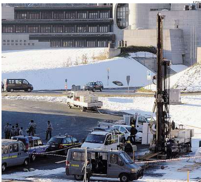
► La trivella in azione sul piazzale delle sede Sita a Susa a fianco dell'autostrada
