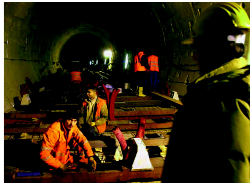
CANTIERI A giungo si reciteranno i terreni dove verrà realizzato il tunnel geognostico
