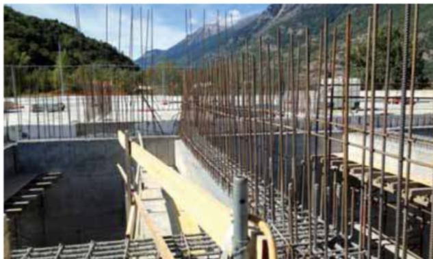
Nelle foto, i lavori per la realizzazione delle condotte del serbatoio di Chiomonte
