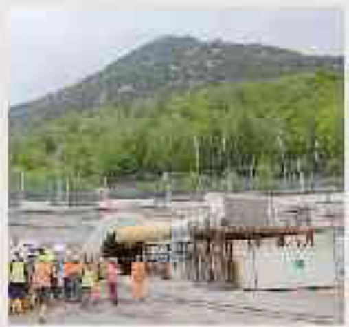
Cantiere di Chiomonte
