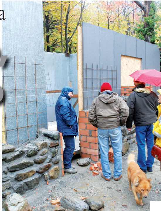
Il presidio della Maddalena, a Chiomonte, in fase di costruzione nei pressi dell'imbocco del tunnel geognostico. Sotto: il sindaco Renzo Pinard
