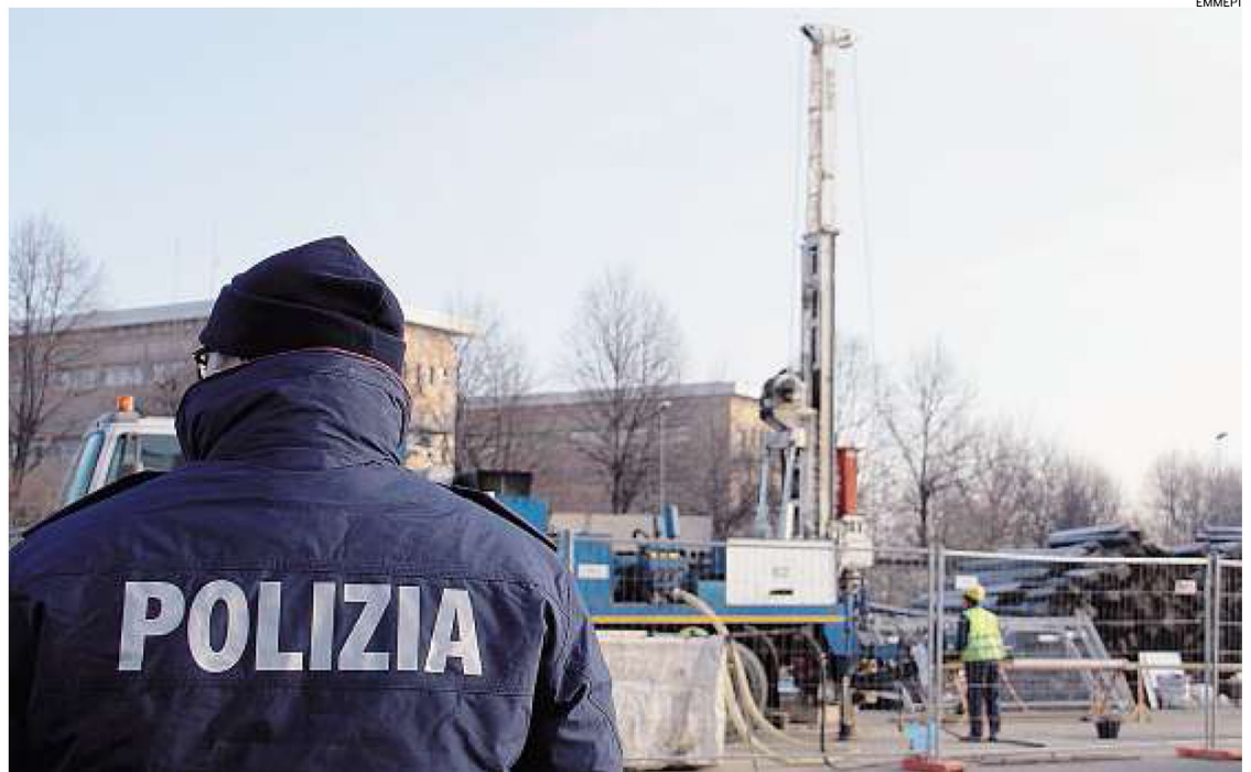
► Il cantiere dei sondaggi alla stazione di Collegno
