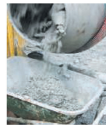
La betoniera sabato al lavoro
