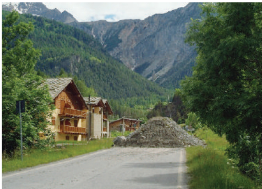
È stato realizzato un vallo paramassi in terra a protezione della strada e delle abitazioni della frazione
