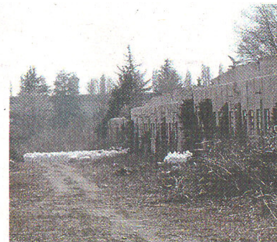
Alle Casermette è in corso il lavoro di bonifica dall'amianto: il materiale nocivo viene raccolto e conservato in sacchi destinati alla discarica
