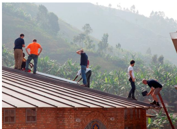
al lavoro sul tetto Piola al lavoro
