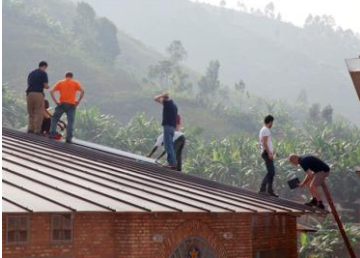
al lavoro sul tetto
